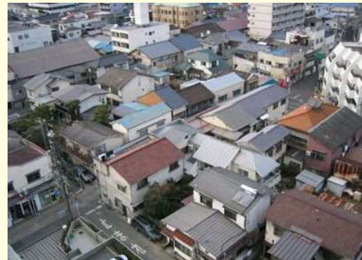
老朽化した木造家屋が密集しているため、防災上、問題があります。
