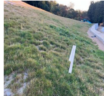
図 1 5 緑化シート施工 (10月)
