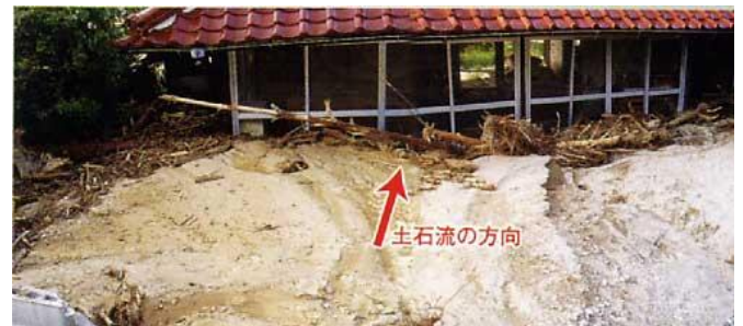
図2 平成17年9月 玖島地区土砂災害
