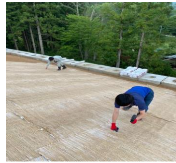
図 1 4 緑化シート施工 (5月)
