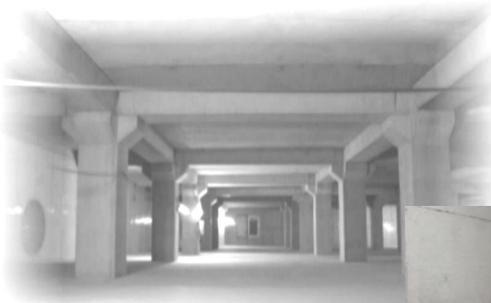
大州雨水貯留池の内部
