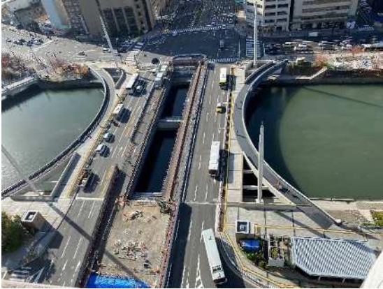
駅前大橋の改修作業
