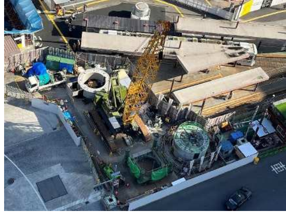
路面電車高架基礎工事
