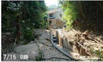
⑦被災したMさん宅 1階部分が一部損壊。宅内には 大量の土砂が流入した
