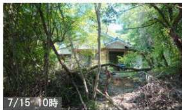
⑬土石流脇の家屋 土石流の痕跡から10mほどの 空き屋は無傷で残っていた
