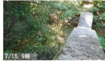
⑨被災箇所付近の治山えん堤 治山えん堤がある溪流は土石 流が発生しなかった
