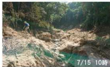
⑭土石流区間の上流部 幅10~20m、土砂厚30cmほど の不安定土砂が残っている
