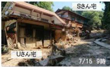
⑩被災したSさん宅ほか Sさん宅は1階部分がえぐられ損 壊。
