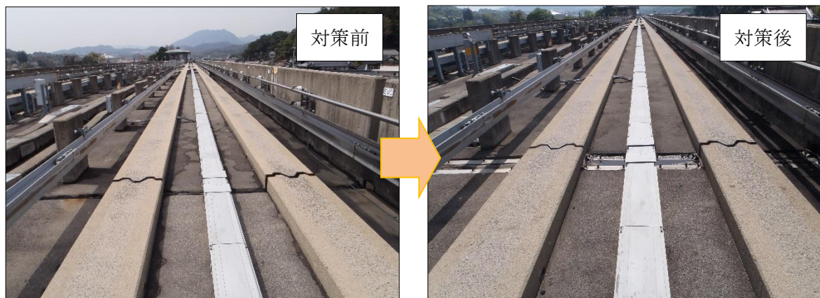
図-1.3.12 伸縮装置の取換え
