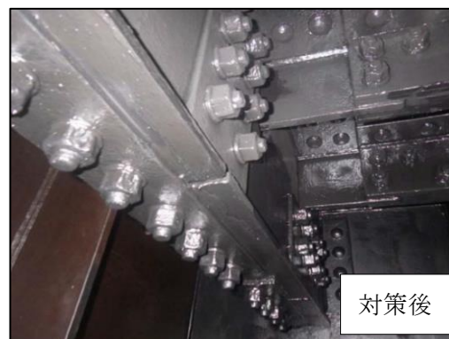
写真 3 当て板補強の対策状況
