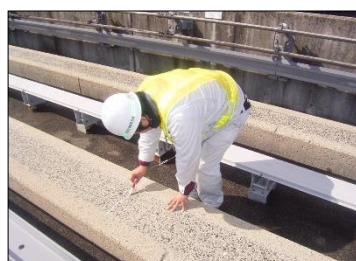
軌道内近接目視点検
