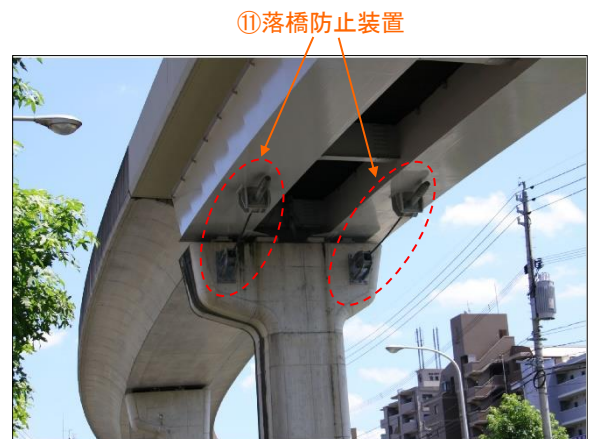
[参考図5] 落橋防止装置
