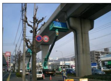
軌道外点検状況
