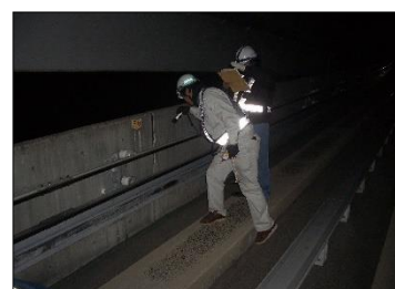
軌道内近接目視点検状況
