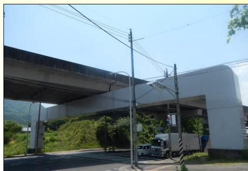
例) 交差点内で、中央分離帯内に橋脚設置スペースが確保できない場合(鋼製門型橋脚構造で対応)
