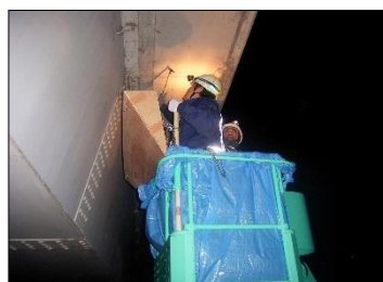
バケット式(ブーム長 27m)作業状況
