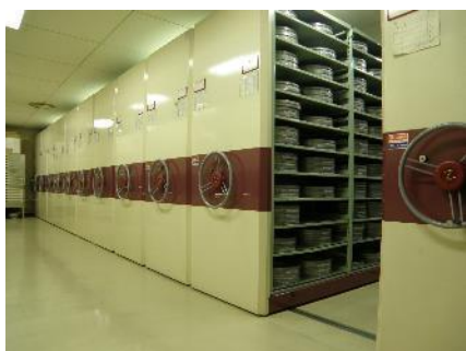
地下1階収蔵庫
