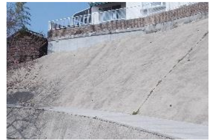
モルタル・コンクリート吹付工
