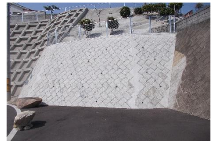
崩壊した崖の本復旧工
