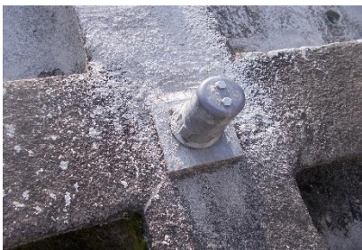
アースアンカー工
