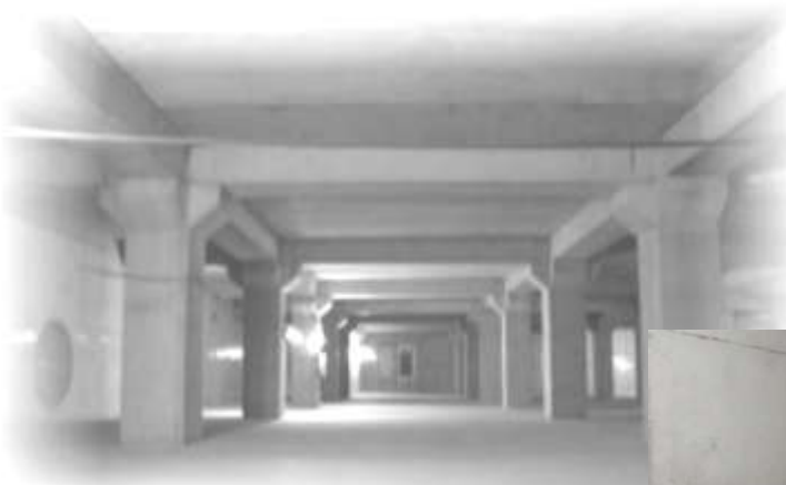
大州雨水貯留池の内部
