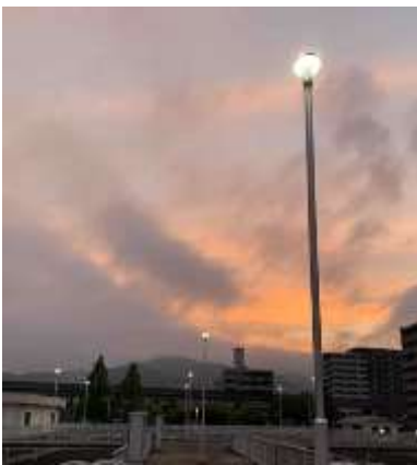
牛田浄水場 LED照明
