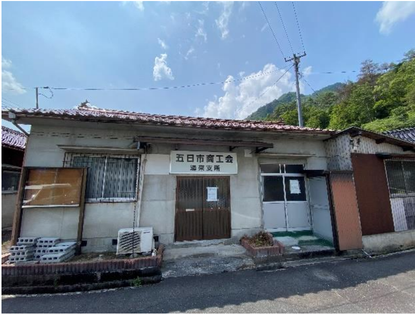
監査人撮影（67.7 m 2 部分の外観）
