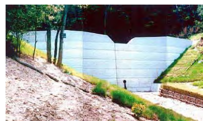
写真 資 5-2 治山堰堤
