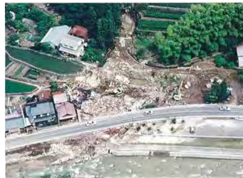
写真 資 2-2 安佐北区安佐町飯室 土石流により宅地や農地に水や土砂が溢れました。
