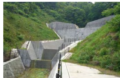
写真 資 5-1 砂防堰堤
