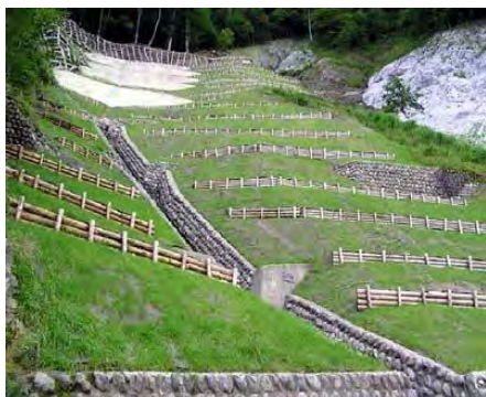
写真 資 5-3 土留工の例
