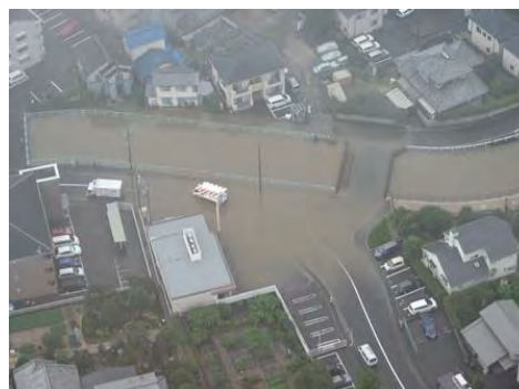
写真 資 2-8 安佐南区長東三丁目付近 新安川の内水氾濫により周辺の住宅や道路が浸水被害を受けました。
