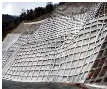
写真 資 5-4 のり枠工の例
