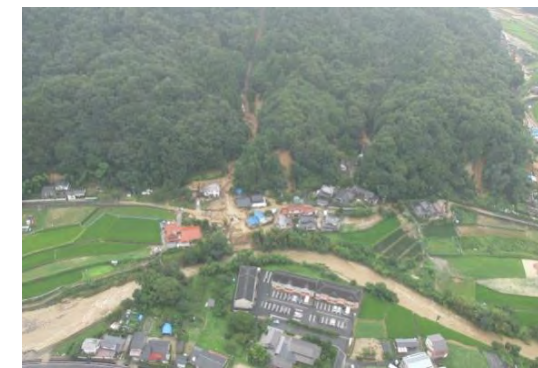
写真 5-14 大林町代田地区根谷川周辺 高山の谷筋での土石流が住宅や農地に被害を発生させました。
