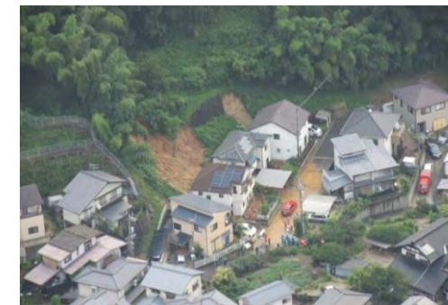
写真 5-5 山本八丁目付近 住宅地背後の急傾斜地が崩壊し、家屋の 1 階で寝ていた幼い二人の命を奪う被害が生じました。
