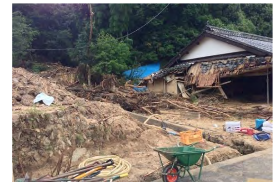
写真 5-15 大林町代田地区の被災家屋 住宅横の谷筋からの土石流により住宅が破壊されました。
