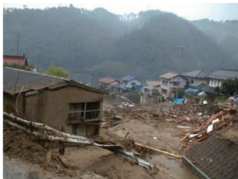
写真 資 2-1 佐伯区五日市町上河内 堂ヶ原川で発生した土石流により住宅や道路が被害を受けました。
