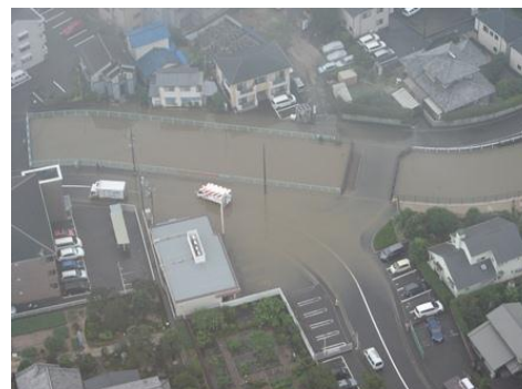
写真 資 2-8 安佐南区長束三丁目付近 新安川の内水氾濫により周辺の住宅や道路が浸水被害を受けました。
