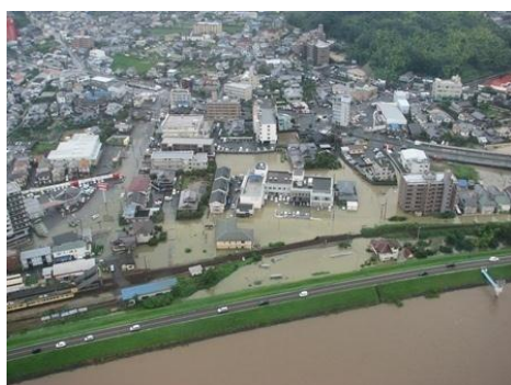
写真 資 2-7 安佐北区口田一丁目付近 矢口川の内水氾濫により周辺の住宅や道路が浸水被害を受けました。
