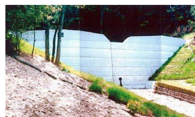
写真 資 5-2 治山堰堤
