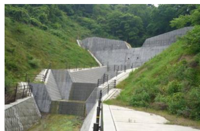
写真 資 5-1 砂防堰堤
