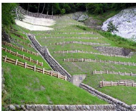
写真 資 5-3 土留工の例
