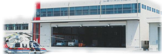
【広島市消防航空隊基地】
