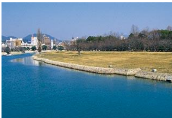
図 太田川基町環境護岸
