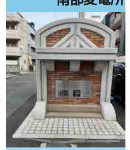
原爆投下の翌日、即送電開始。地域に復興の光(電気)を届けた。鉄骨の電柱は現役。
