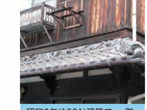
昭和6年(1931)建築で、一階の屋根には伊予製の鶴亀鯛などの瓦が使われている。
