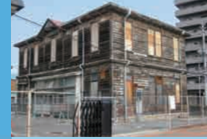
明治42年(1909)に建てられた木造洋風建築で、左右対称に造られている。現在立入禁止。
