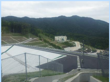
貯留堰堤の管理道路をアスファルト舗装しました。今後、場内管理道路をアスファルト舗装していく予定です。
