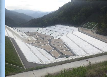
埋立地内の浸出水を集水して浸出水調整池に導水するための浸出水集排水管を設置しました。
