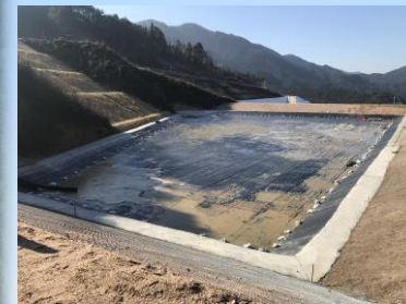
埋立地の上流側に暫定沈砂池を設置しました。
