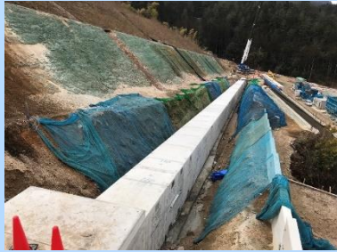
ボックスカルバートを設置しました。
