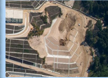
覆土置場の法面工を施工しています。
