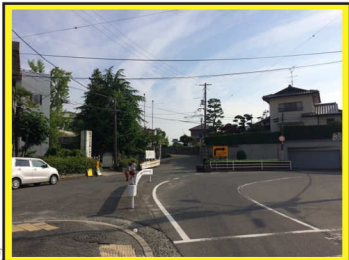
現在、道路（2車線）を整備中。連立事業で整備する東西幹線道路と一体となって、地区の交通の円滑化が期待されます。
