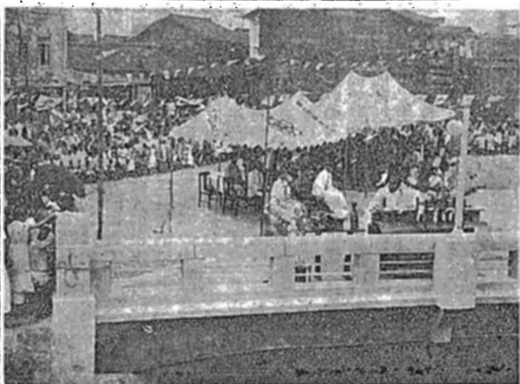
舟入皆實線第二區 街路線工事竣工
