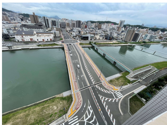
東雲大州線(東大橋)
