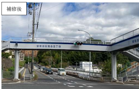
附属物(横断歩道橋)
