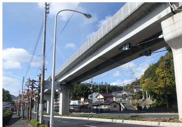
アstromライン（高架橋）の耐震化
