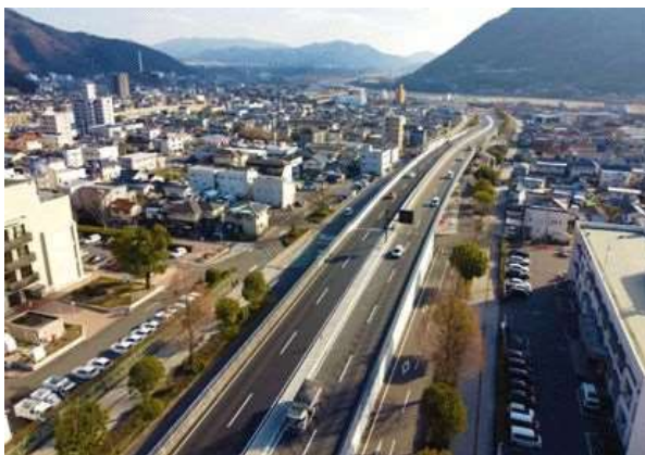
一般国道54号 可部バイパスの様子 〔写真提供：国土交通省 広島国道事務所〕
