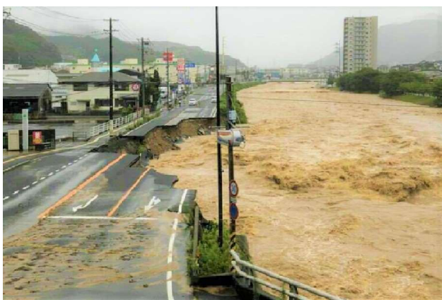
①国道2号 (広島市安芸区中野東)
