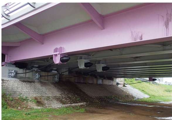
橋りょうの耐震化
