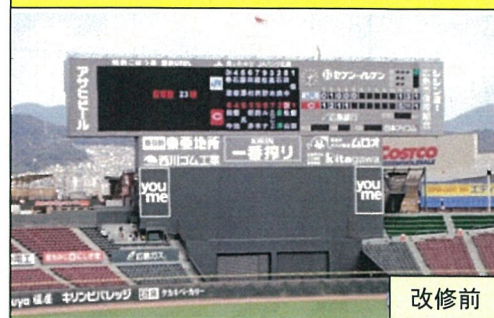
ア:電光式スコアボード設備等改修工事
