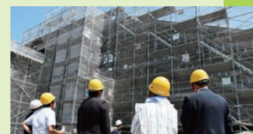
西広島駅自由通路等整備工事現場視察 (7月撮影)
