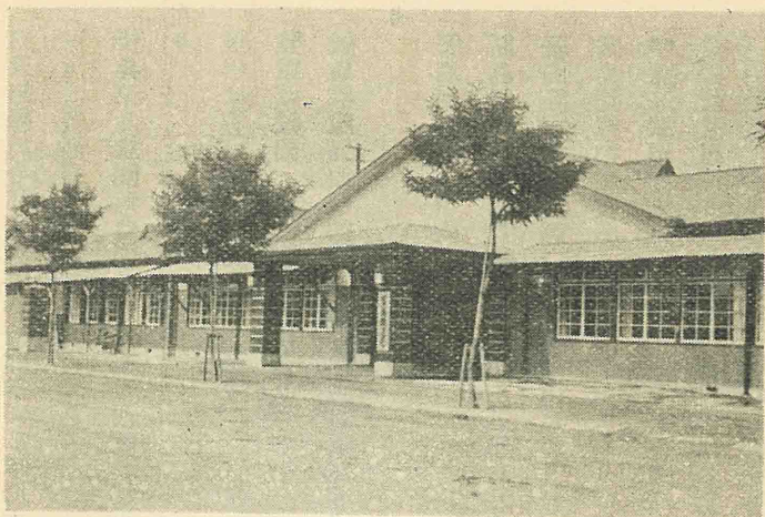
廣島鐵道局假廳舎
