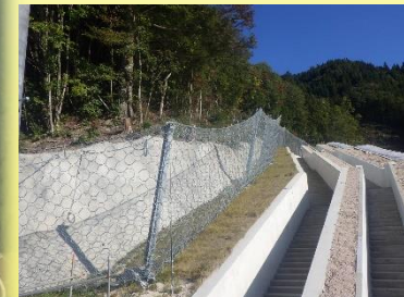
大雨時に周辺の山から流れてくる土砂等が水路に入らないようにするための土砂流入防止施設を設置しています。
