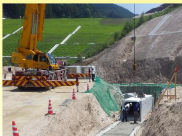
場内に降った雨を防災調整池に排水するためのBOXカルバートを設置しています。
