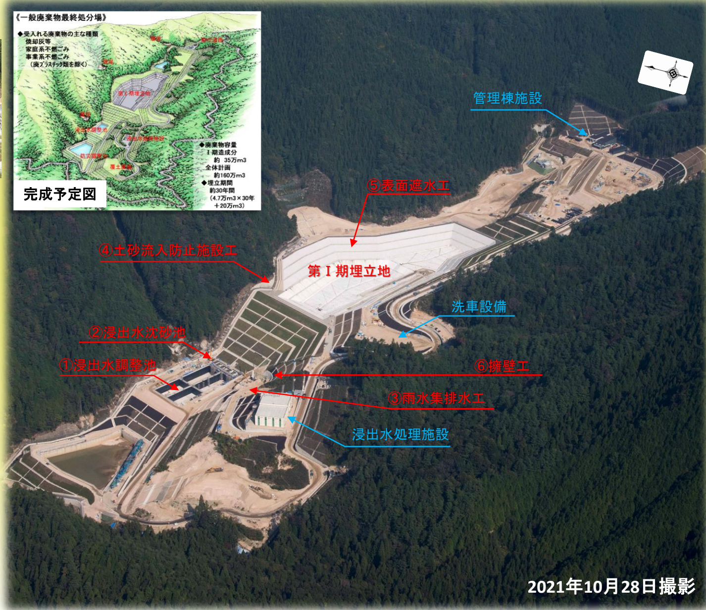
大雨時に周辺の山から流れてくる土砂等が水路に入らないようにするための土砂流入防止施設を設置しています。
