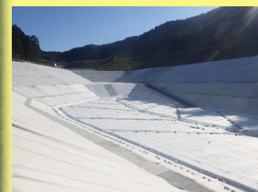
第Ⅰ期埋立地内の遮水シートの敷設がまもなく完成します。
