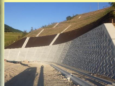
場内管理道路に沿ってコンクリートブロック積擁壁を設置しています。
