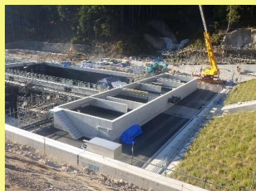
埋立地から流入する浸出水を沈砂池で受け止めて、砂を洗め、うわ水を調整池に流します。
