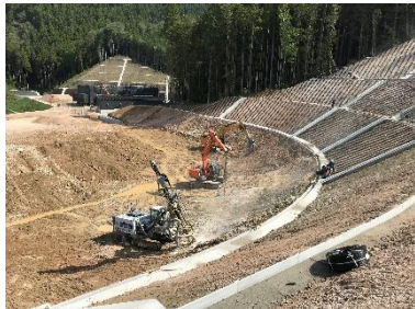
岩盤部の切土掘削を行っています。
