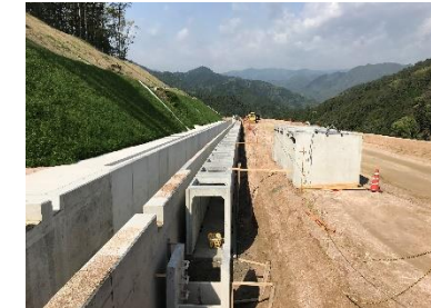
管理道路に沿って雨水排水施設の設置を行っています。
