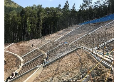
連続繊維補強工を行っています。（詳細は裏面を参照）
