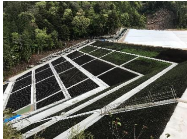
貯留えん堤の法面に植生基材吹付工を行いました。
