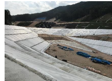
第1期埋立地内の遮水シート敷設および固定工の打設を行っています。
