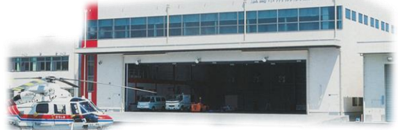
【広島市消防航空隊基地】
