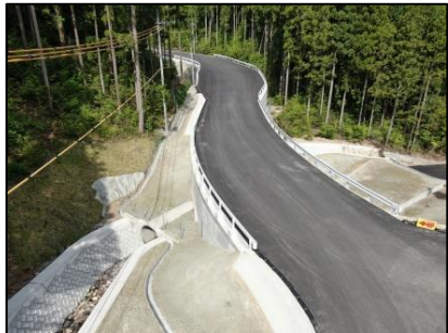
①取付道路工
