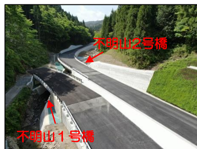
⑥橋りょう工
