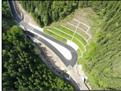
③法面工（終点部）
