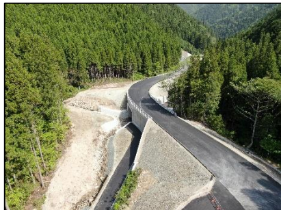
④函渠工(1号)
