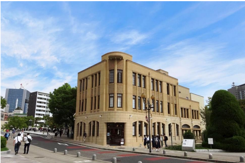
(改修後のレストハウスの外観)
