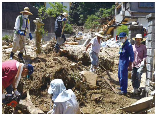
写真 2-13-1 ボランティアによる土砂等の撤去
