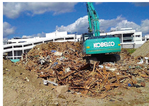
写真 2-1-2 がれき混じり土砂等の処理の様子
