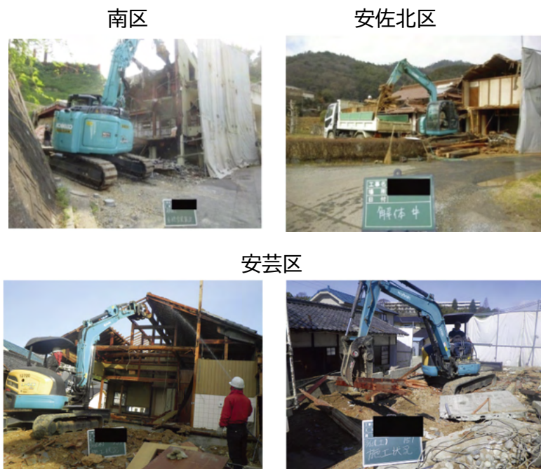
写真2-9-4 被災家屋の解体・撤去の状況
