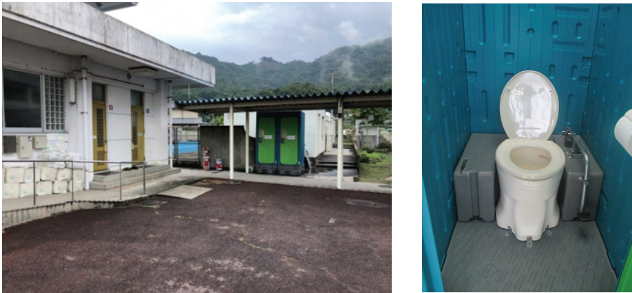
写真 2-5-2 避難所に設置した仮設トイレ
