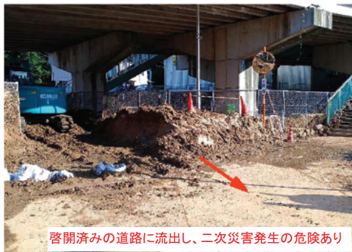
写真 2-9-2 土砂等の撤去箇所の状況（二次災害発生の危険あり）その1
