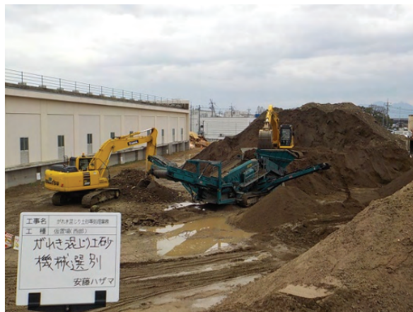
写真 2-9-6 使用した振動式選別機（土砂系の選別）
