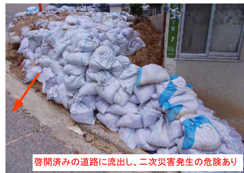
写真 2-9-3 土砂等の撤去箇所の状況（二次災害発生の危険あり）その2
