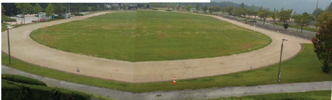
写真 2-8-3 仮置場の運用時・復旧後の状況（瀬野川公園）
