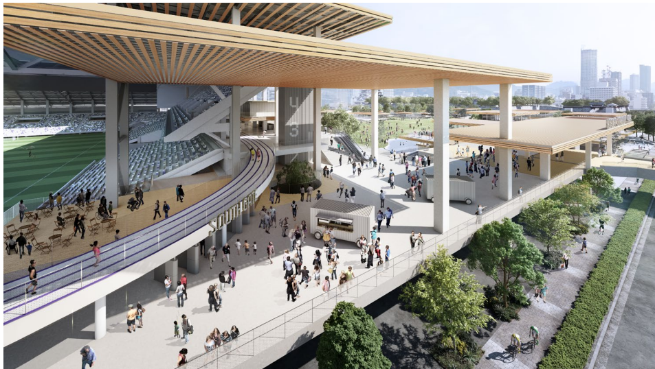
ランニングトラックや本川への回遊動線として 通年のにぎわいを生むビッグデッキ（コンコース）
