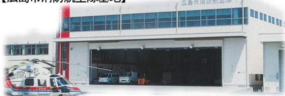
【広島市消防航空隊基地】
