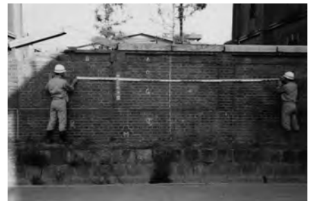
資料館へ移設する広島陸軍被服支廠のレンガ塀の切り出し 1972年(昭和47年)
