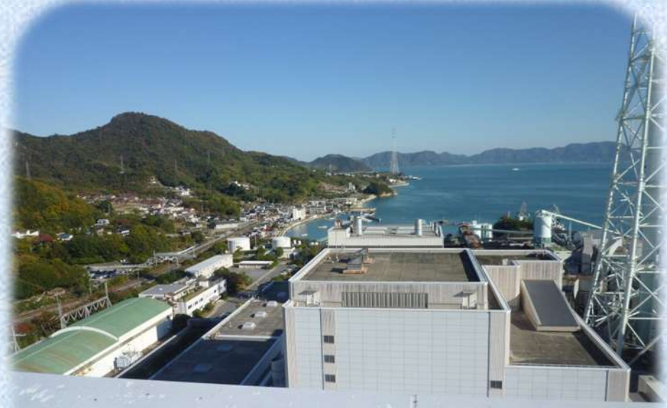
JP竹原火力発電所※屋上からの風景
