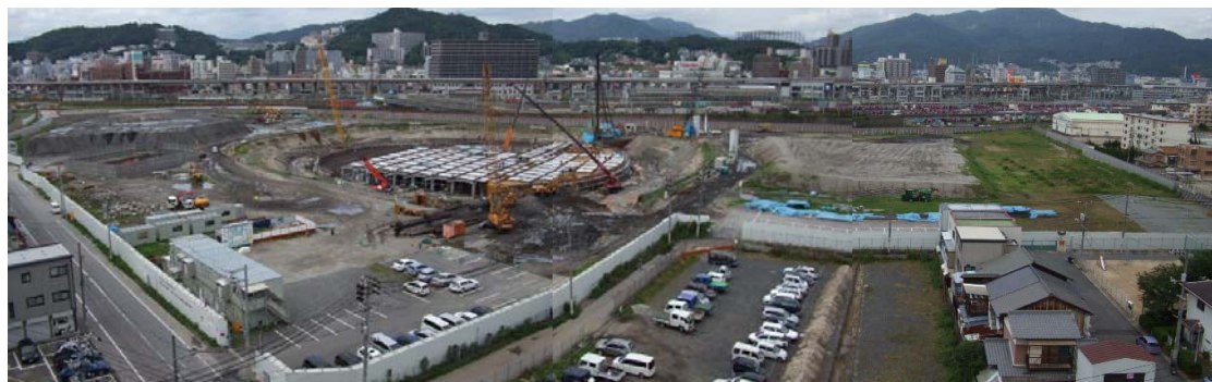
雨水貯留池築造施工状況写真
