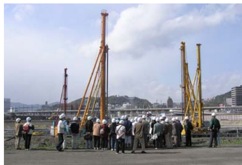
粉体噴射工法見学状況写真
