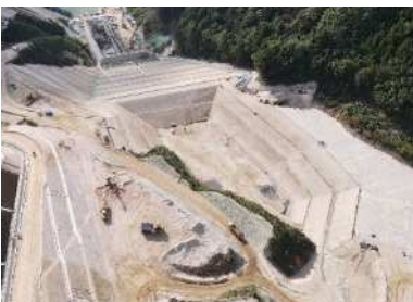
第Ⅰ期埋立地の切土・盛土を行っています。
