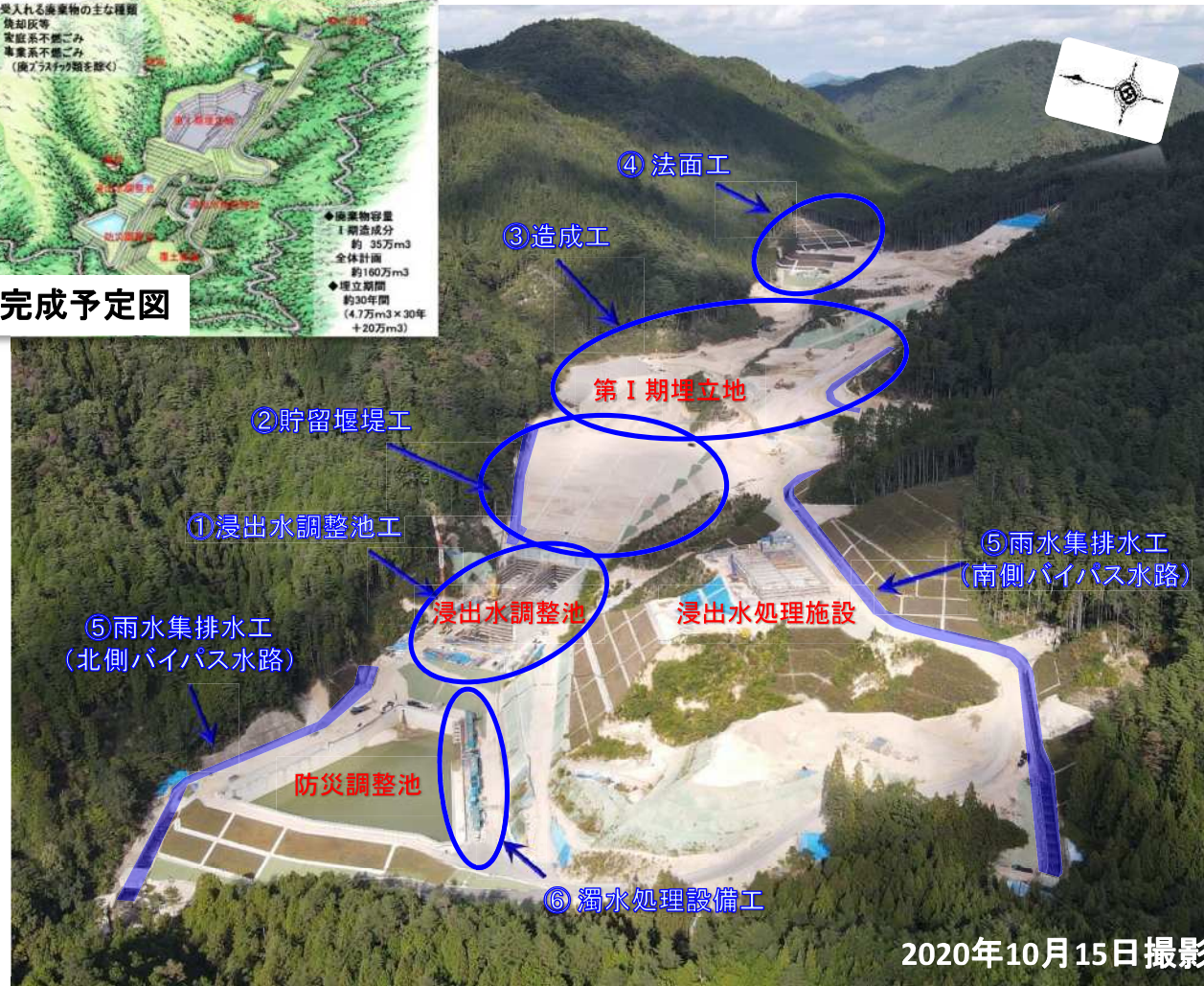
セメント改良土を用いて、貯留堰堤工事を行っています。
