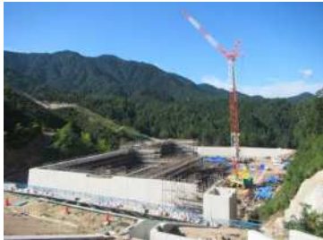
浸出水調整池の躯体工事を行っています。
