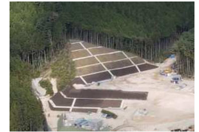
造成工事の進捗に合わせて、植生基材吹付を行っています。
