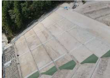
セメント改良土を用いて、貯留堰堤工事を行っています。
