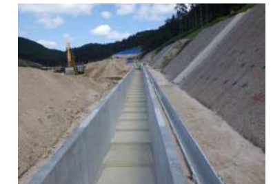
南側バイパス水路および北側バイパス水路の設置を引き続き行っています。
