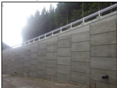
②補強土壁工
