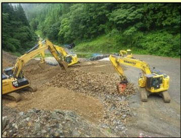
《①土砂選別・小割状況》
