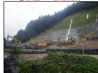
④法面工（終点部）
