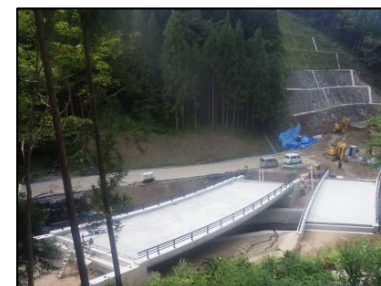
⑦橋りょう工
