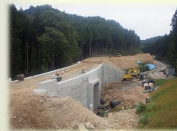
本線 路体・路床盛土状況
