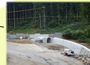
取付道路部施工状況
