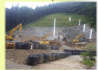
終点部法面掘削状況
