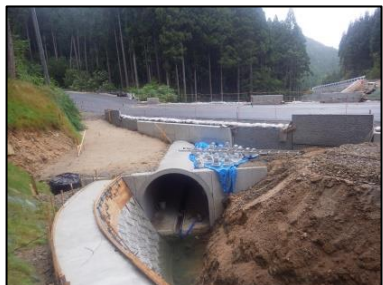
①取付道路工
