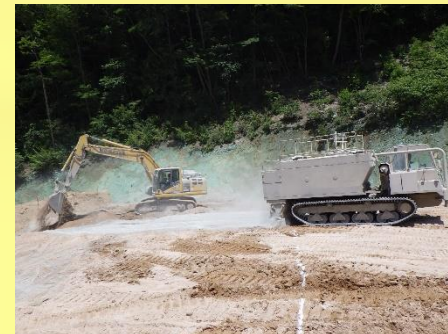
安定処理状況
