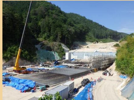
底盤配筋状況
