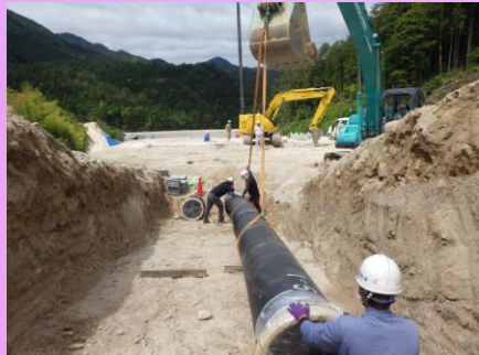
ポリエチレン管敷設状況
