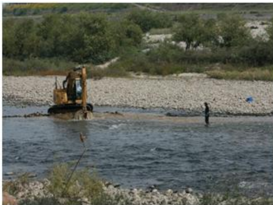
産卵場の造成（安佐南区東野付近 左：重機による川床の整備 右：人力による整地作業）
