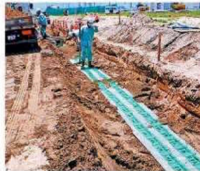
ガス管標識シート・防護鉄板設置
