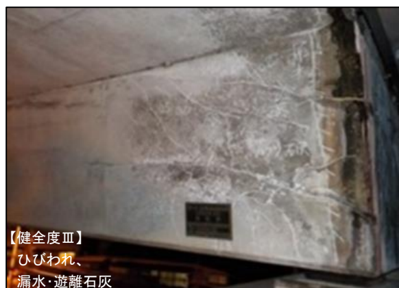
写真-1 橋の損傷事例（PC桁）
