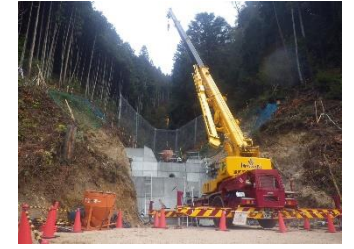
北B溪流の土石流を防止する堰堤を施工しています。
