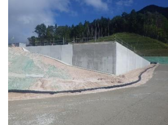
浸出水処理施設の敷地を確保するためにL型擁壁を施工しました。
