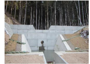
北F溪流の土石流を防止する堰堤を施工しました。
