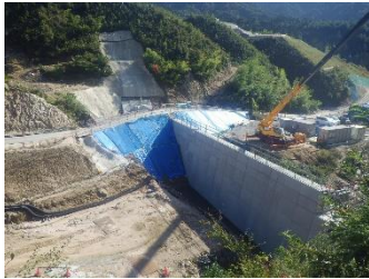
浸出水の流出防止と貯留堰堤の法留の機能を果たす法留擁壁の施工を行いました。
