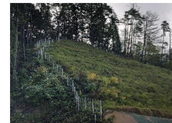
高さ1.5mの侵入防止柵を設置しました。
