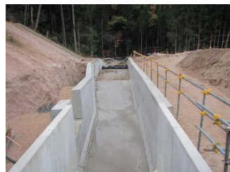
南側パイパス水路の施工を行いました。
