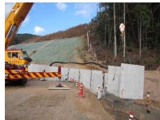
クレーンを使用して大型水路の据付作業を行っています。
