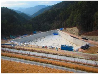
防災調整池躯体が完成しました。
