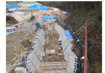
現場下流にある河川の護岸工事を行っています。
