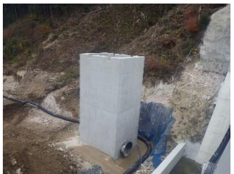
地下水に浸出水が混入していないか常時監視する施設を施工しました。
