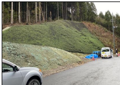
①法面工(切土部)
