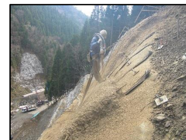
④法面工(終点部)
