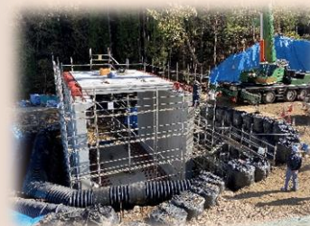
1号函渠据付作業
