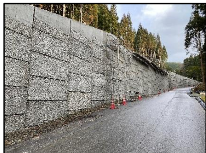
②補強土壁工
