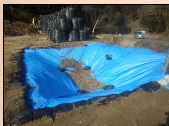
≪終点部に設置している沈砂池≫
