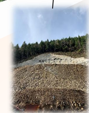
終点部法面掘削状況
