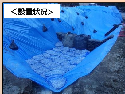
≪沈砂池内に設置している水質浄化材≫
