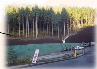
起点部法面掘削状況
