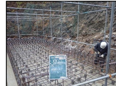
⑦橋りょう工
