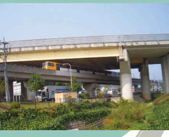
県道・アストラムライン・山陽自動車道の3層構造
