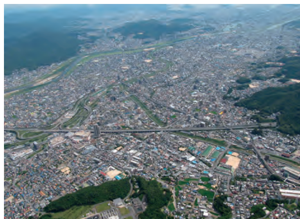
デルタ周辺部(広島インターチェンジ付近)
