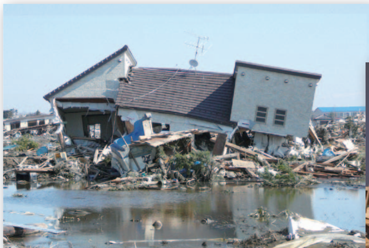
津波による建物倒壊(東日本大震災)
