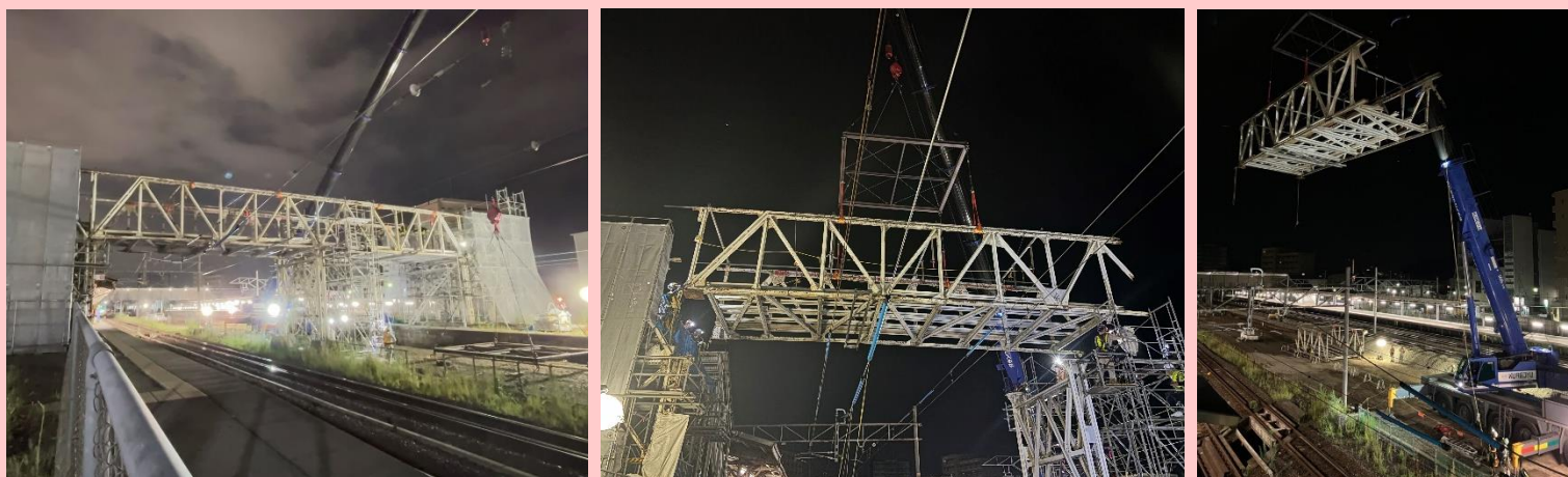
撤去作業の様子
