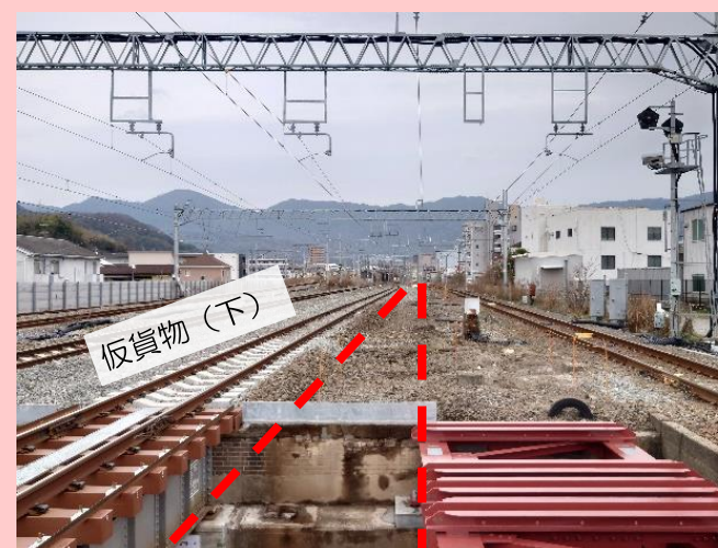
仮線路切り換え後（現在は貨物下り線をすでに撤去しています）
