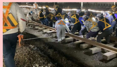
切り換え工事の様子
