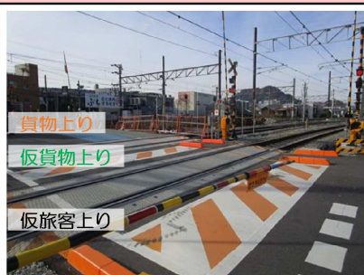
青崎第3踏切から向洋駅方向
