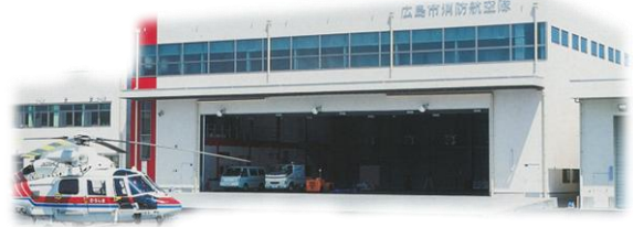
【広島市消防航空隊基地】
