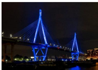
橋梁のライトアップ
