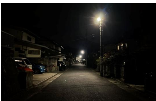
暗くて不安を感じる団地内道路
